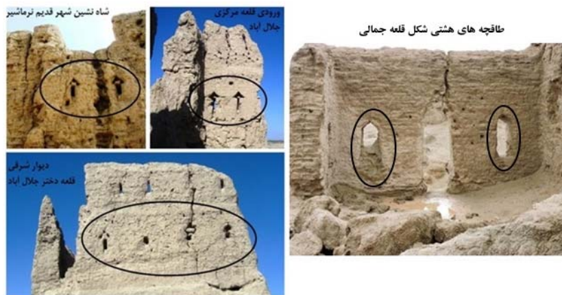
تصویر ۳. پنجره با طاق هشتی شکل، روزنه‌های دیده‌بانی و تیرکش‌های فلش‌مانند
